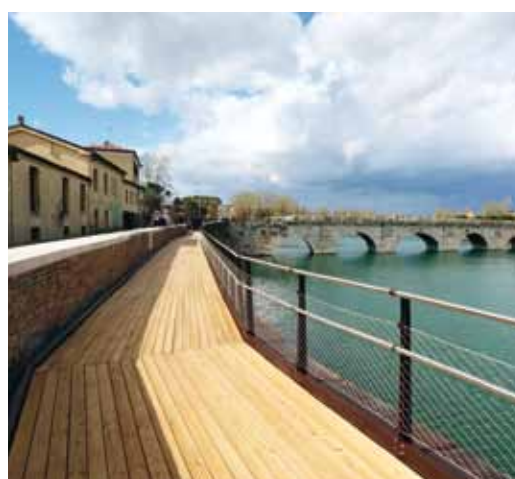
La nuova passerella sospesa del Ponte di Tiberio
